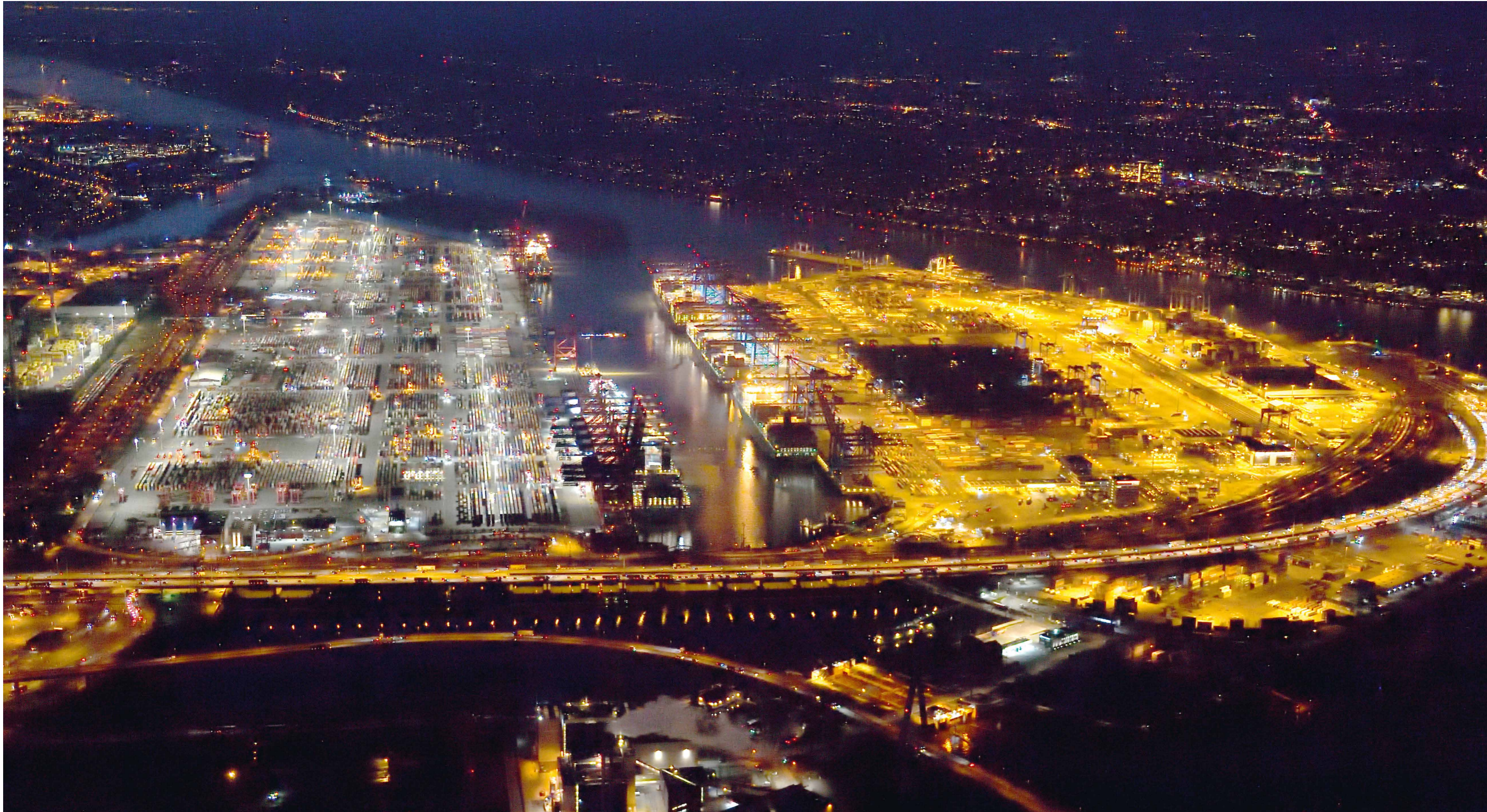
Energieeinsparung durch LED-Beleuchtung am EUROGATE Container Terminal Hamburg.
