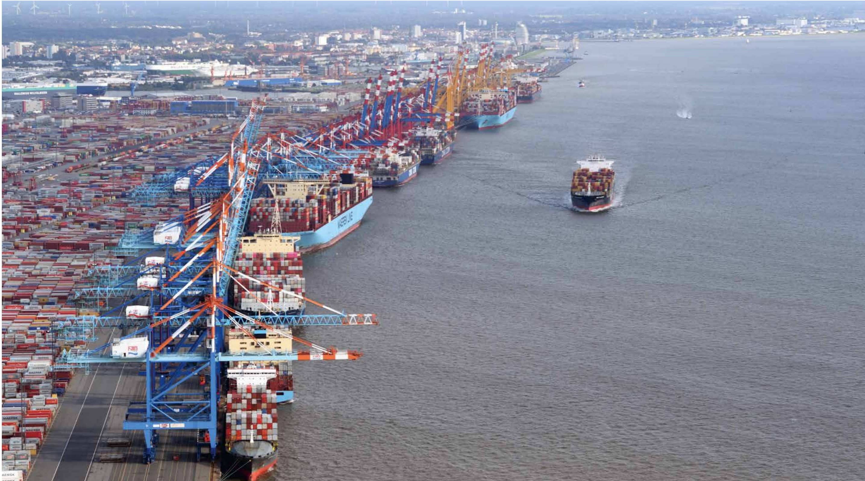
Containerterminals NTB, CTB und MSC Gate in Bremerhaven.
