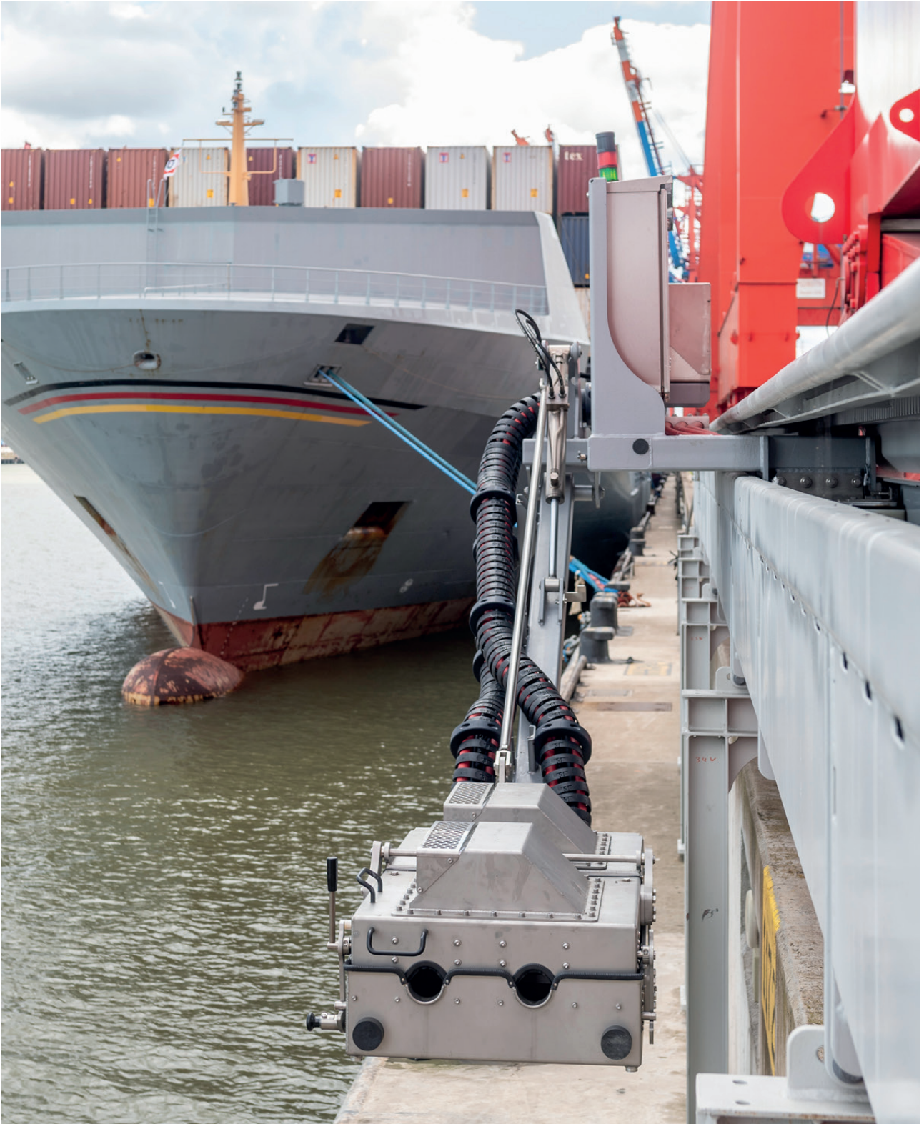
Der Bau der Landstromanlage am EUROGATE Container Terminal Hamburg leistet einen wichtigen Beitrag zur Dekarbonisierung in der Schifffahrt. (© Hamburg Port Authority, Andreas Schmidt-Wiethoff)
